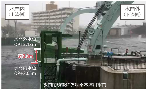
平成30年台風21号襲来時の三大水門閉鎖状況【資料提供：大阪府】
