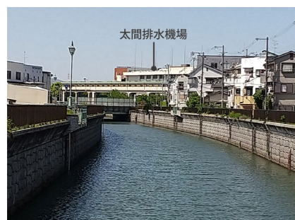
写真3 寝屋川導水路(前方は太間排水機場)
